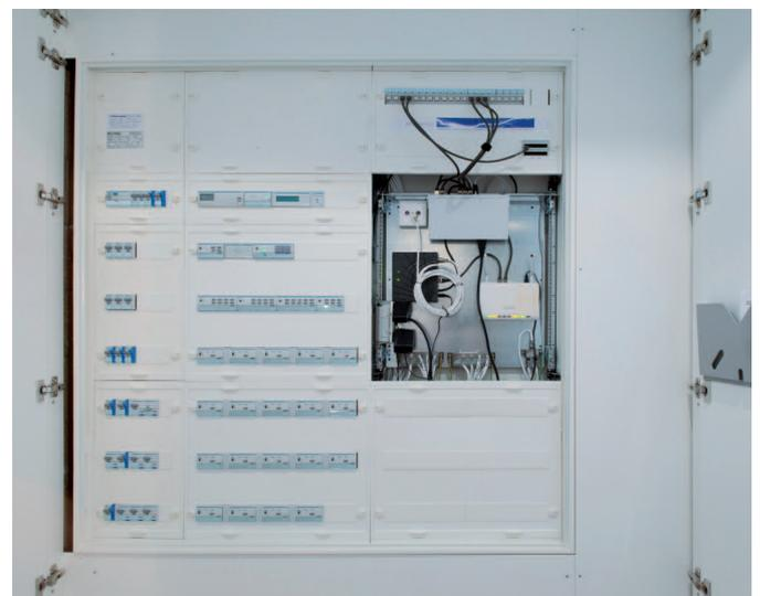
Unterverteilung im Hager Look: Links die Schutz-, Steuer- und Messgeräte für die Energieverteilung, in der Mitte die Modulargeräte für die Gebäudesteuerung und rechts das Mediafeld mit Fernseh-abgängen, Modem, Router und Switches.
